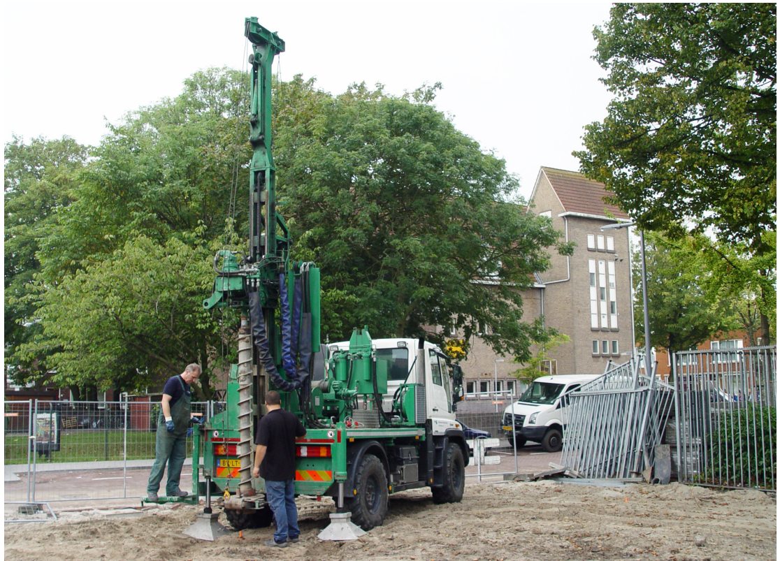
Afb. 6. In tweede instantie is geboord met de zogenaamde Holle Avegaarboor. Wegens te grote wateroverspanning in de ondergrond kon vanaf circa 10,0 m - mv echter geen zand opgeboord worden. Uiteindelijk zijn (het restant van) de boringen uitgevoerd met het zogenaamde GW Akkerman steekapparaat.
